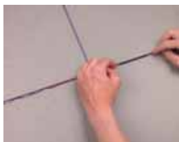
7. umístění drátů do spár
