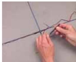
3. navléknutí ochranné krytky spoje
