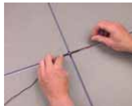
2. úprava drátů do spár
