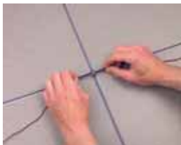
1. vložení do spáry
