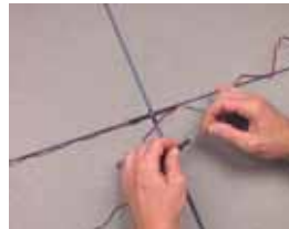
5. převlečení ochranné krytky přes spoj
