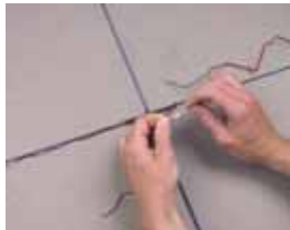
4. spojení konektorů diod
